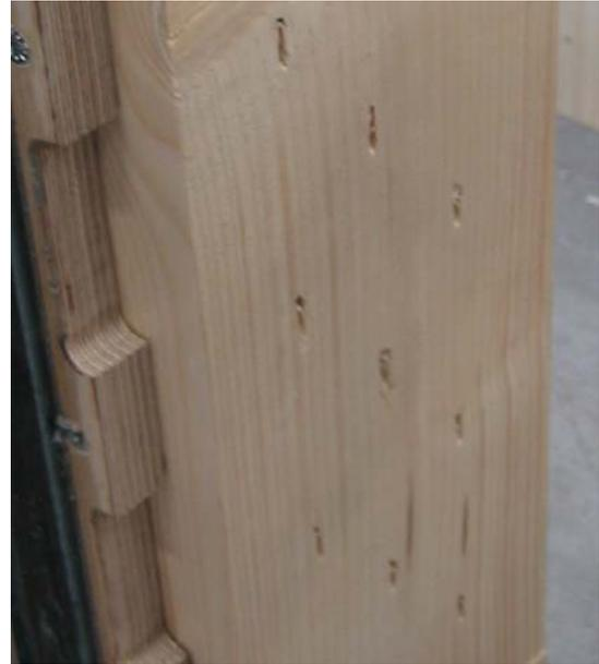
**Abbildung 108: Schädigung des Stieles**
