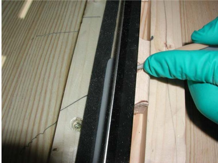
**Abbildung 73: Seitliches Ausspritzen der Fuge mit einem viskosen Klebstoff**
