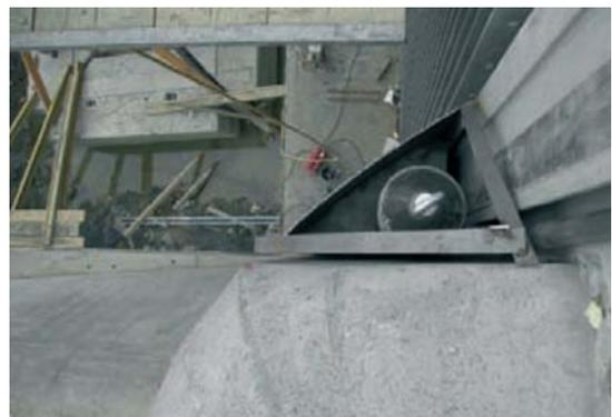
**Abb. 3.95: Zusatzvariante für Trennpfeiler mit Nischenverschluss am Beispiel KW Leoben (VERBUND 2006)**
