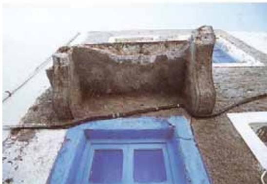
Abb. 870: Korrodierte Stahlbetonbalkone - Nisyros
