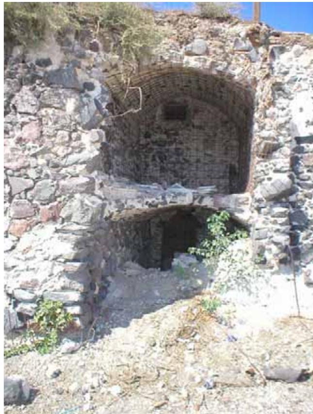
Abb. 883: nachträgliche Verstärkung aus Stahlbeton - Santorin
