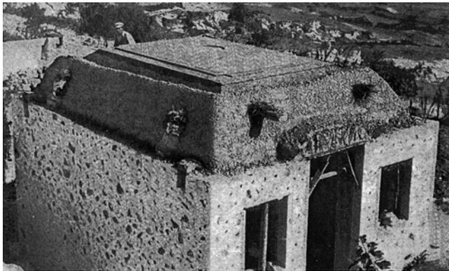
Abb. 559: Herstellung eines Skafoidgewölbes: Santorin
