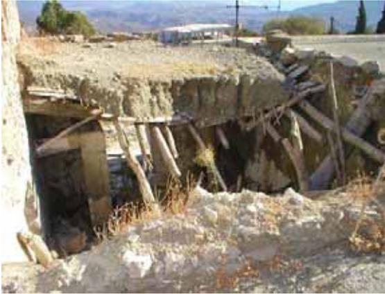
Abb. 820: dämmende Dachschicht (zu dick): Siánna
