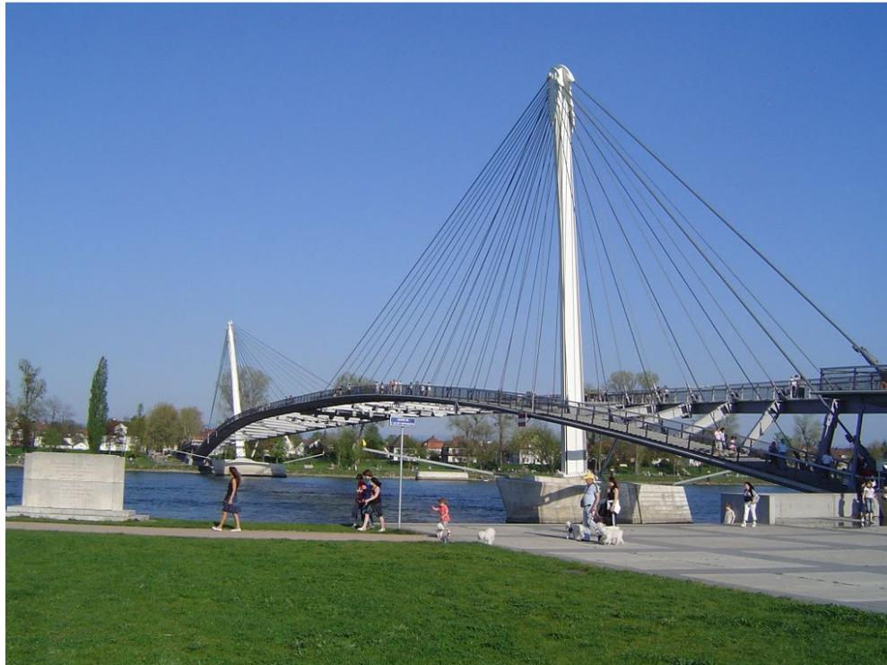
Abbildung 1.16 Beispiel Schrägseilbrücke (Gotsch, 2008)
