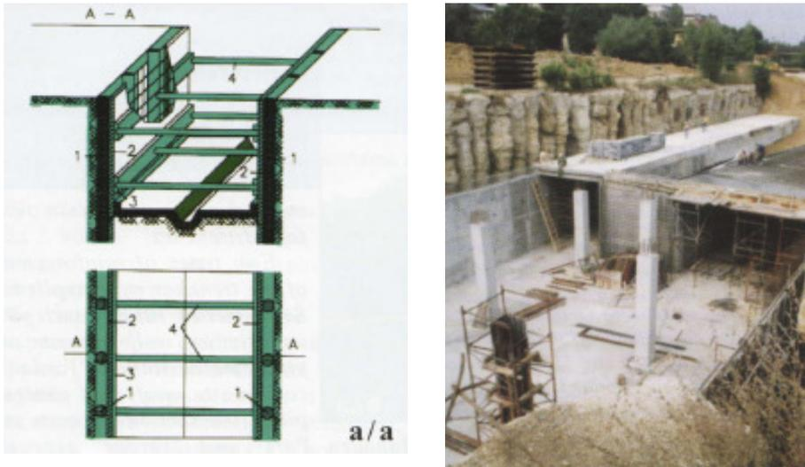
**Abb. 72 Umschließung mit Ortbetonpfählen**
