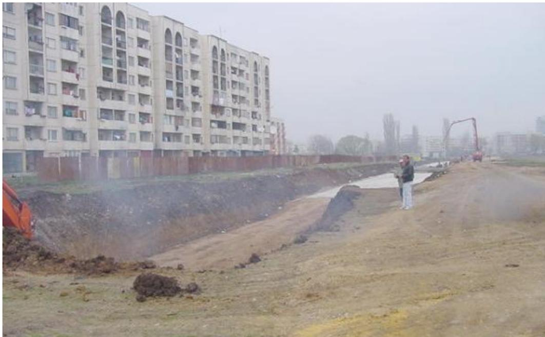
Abb. 64 Herstellung des U-Bahntunnels in offener Bauweise
