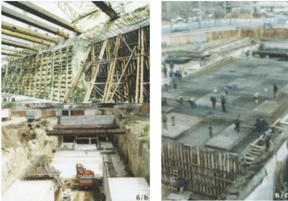
Abb. 73 Sicherung der Baugrube mittels Schlitzwand - Etappe
