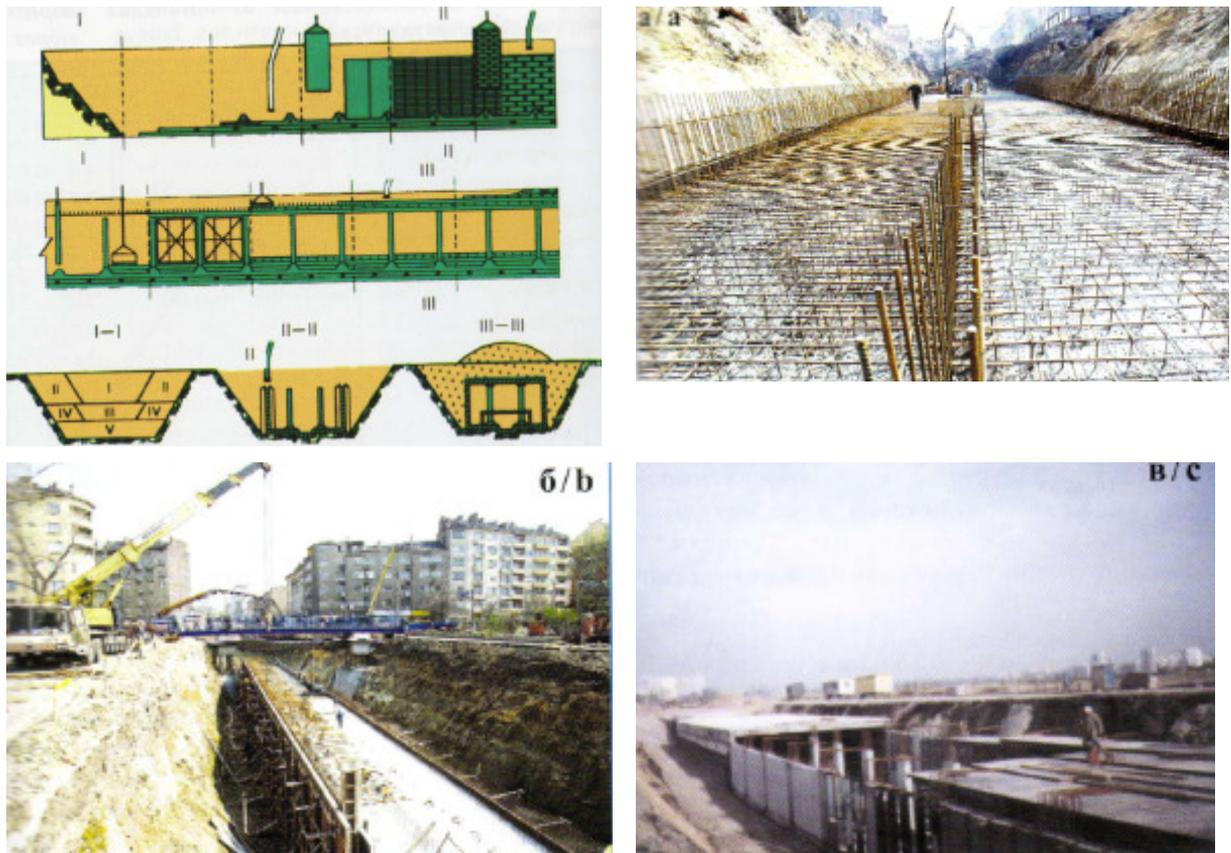
Abb. 69 Ausbau des U-Bahntunnels in Baugrube mit Böschungen
