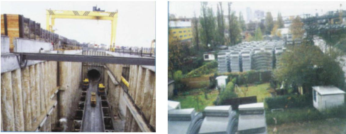
Abb. 77 Startkammer für die TVM und Lager für die Tübbinge
