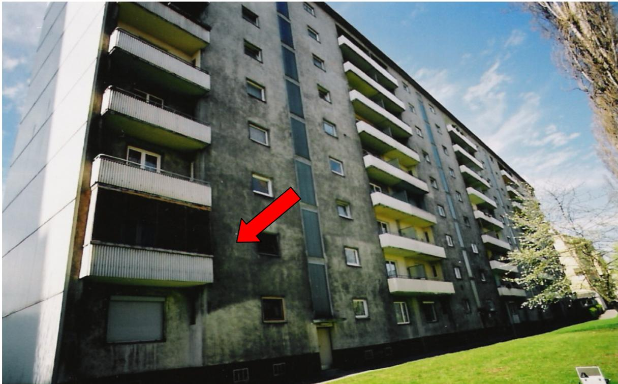
Bild 5-30: Verschmutzung und beginnende Algenbildung an der Außenfassade des Objekts Schlachthausgasse3
