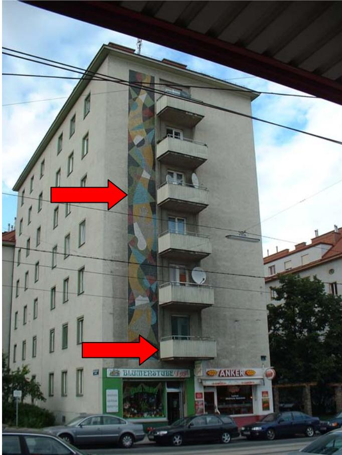
Bild 3-9: Südansicht (Stiege 6); Darstellung der Punkte für eine Wärmebrückenberechnung
