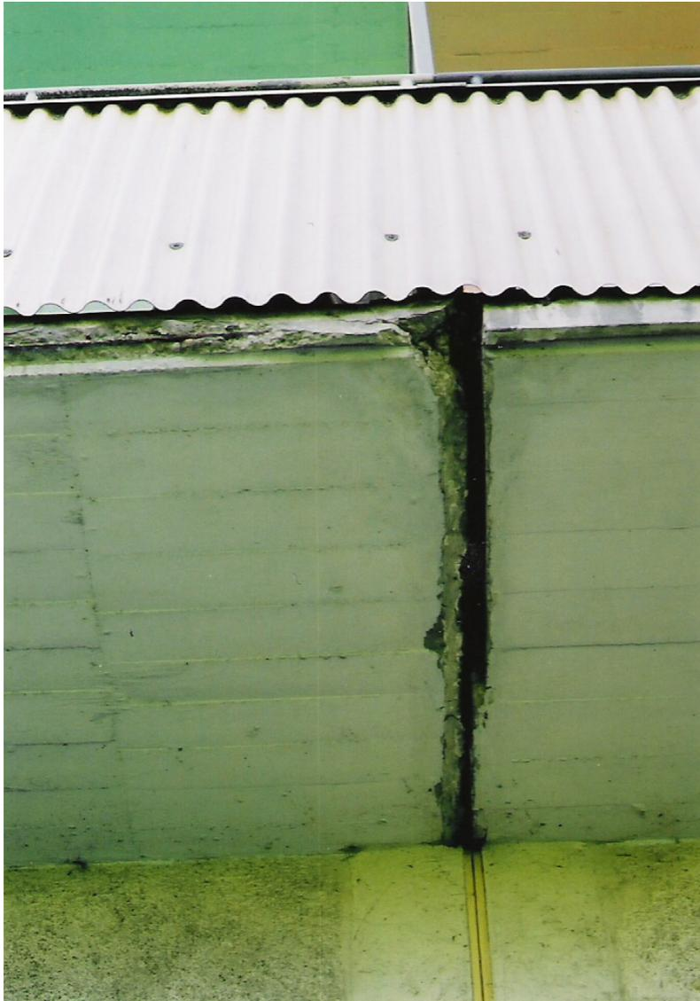
Bild 5-31: Kantenausbruch an der Unterseite einer Balkonplatte
