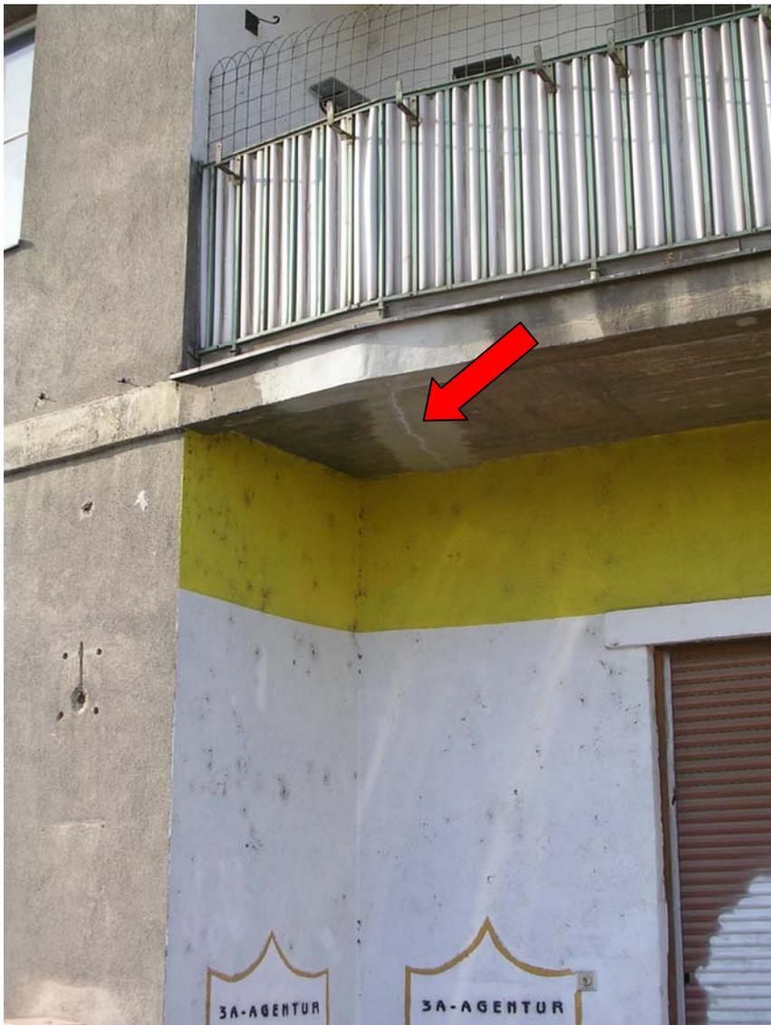
Bild 5-35: Bereits verspachtelter Riss an der Balkonplattenunterseite
