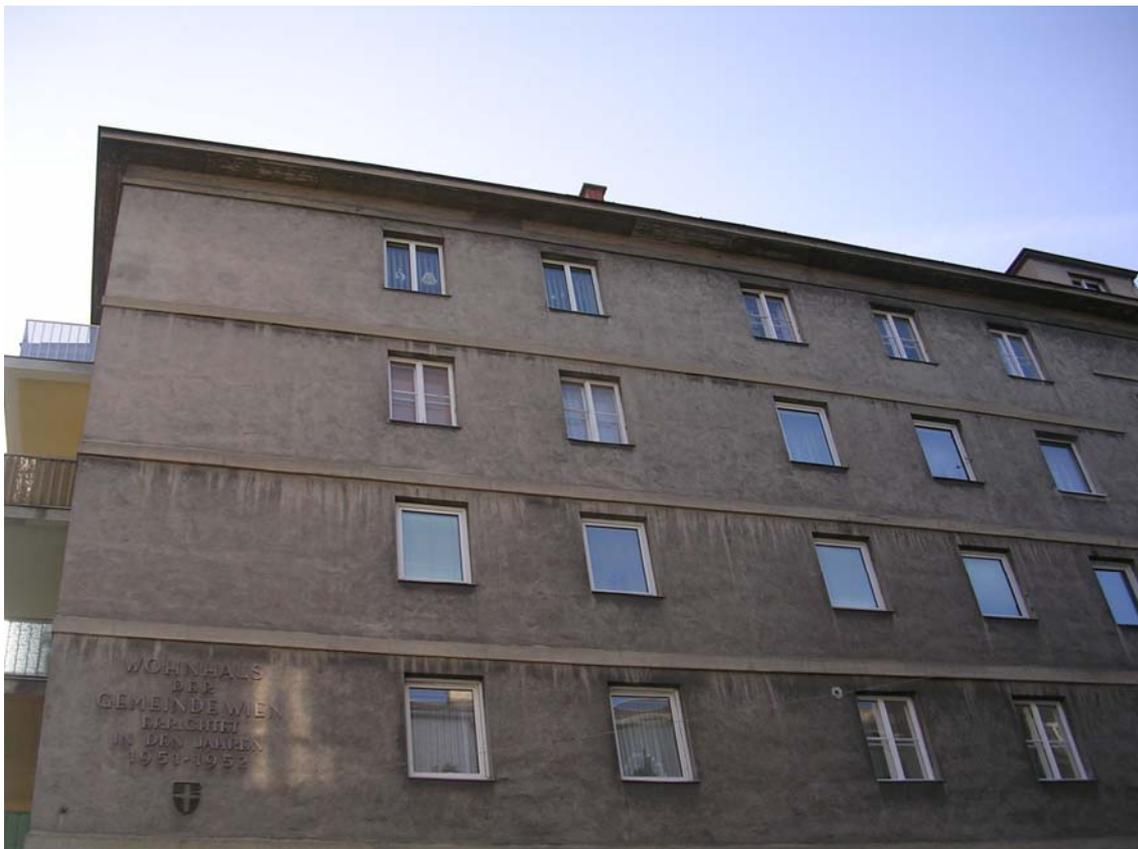
Bild 5-34: Wasserfahnen und Verschmutzungen an der Außenfassade
