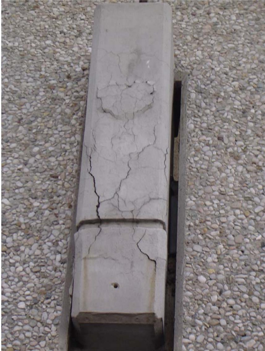
Bild 5-37: Detailansicht der Betonabplatzungen an den Kragstribünen
