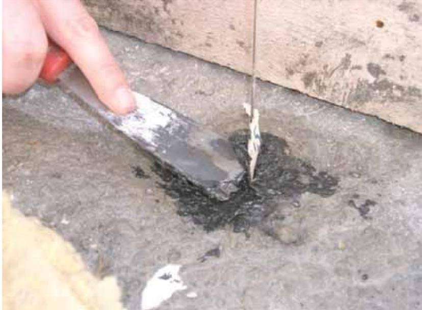
Abbildung 5-5: Abdichten der Betonoberfläche
