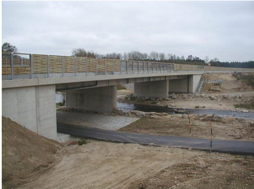
Abbildung 4.19: Ansicht – Integrale Brücke
