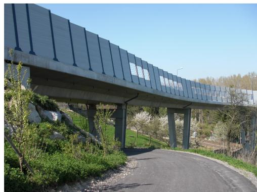
Abbildung 6.1: Brücke – Umfahrung Klosterneuburg, mittlere Pfeiler eingespannt, Randpfeiler und Widerlager durch Lager vom Überbau getrennt
