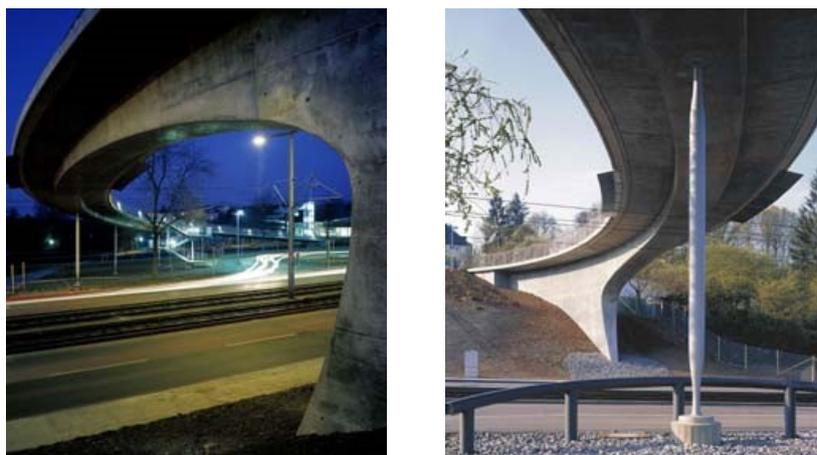
Abbildung 2.22: links: monolithische Einbindung ins Widerlager, rechts: Stahlstütze als Pendelstab ausgeführt [6]
