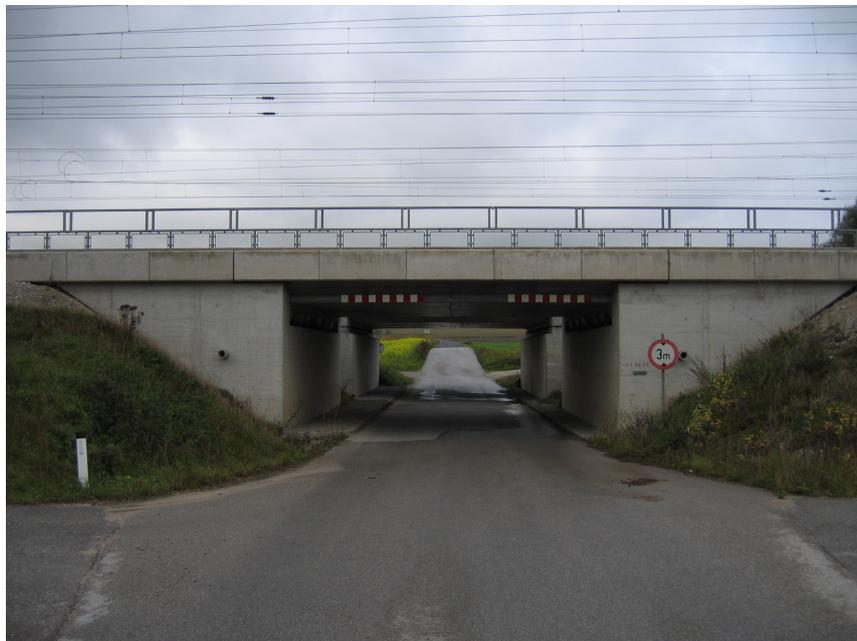
Abbildung 4.1: Ansicht der Brücke *km 133* (Plattenbrücke)
