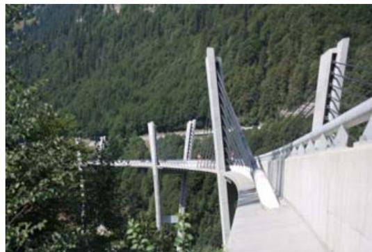
Abbildung 2.20: Sunnibergbrücke – Pylonaufweitung [14]
