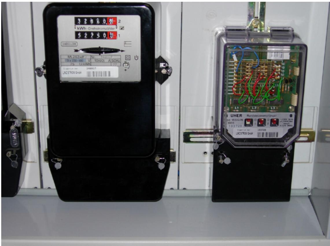
**Abbildung 2.4:** Rundsteuergerät mit zusätzlichen Zähler. Quelle: Author
