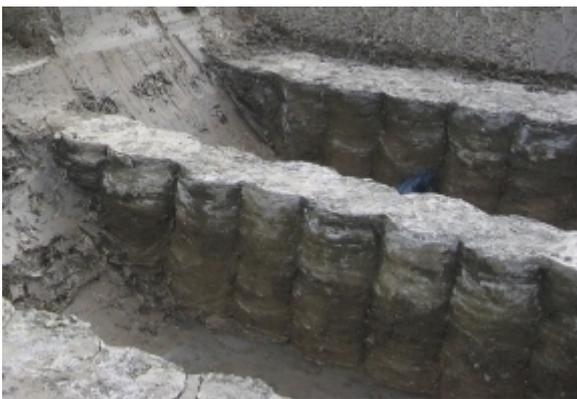
Abbildung 45: Fertigestellte Trockenmischsäulen mit einem Durchmesser von 60 cm [35]
