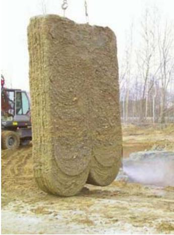
Abbildung 53: Zu Testzwecken ausgegrabenes CSM-Wandelement mit gut erkennbaren Negativabdruck des Fräswerkzeugs [20]
