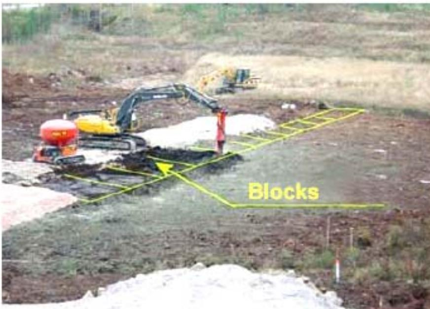
Abbildung 62: Blockstabilisierung [40]
