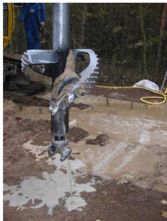
Abbildung 41: Wet Speed Mixing Mischerwerkzeug [58]
