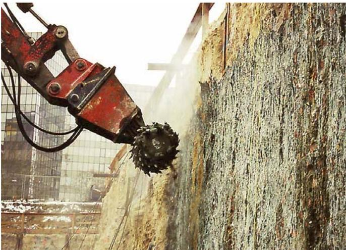
Abbildung 22: Abfräsen einer fertigen MIP-Wand [31]
