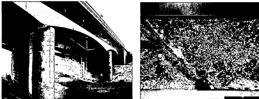
**Bild 5.5.** Melkflussbrücke Winden: Tragwerk und Spannsteelprobe (SIGMA oval)
