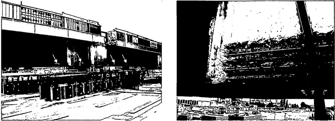
**Bild 5.49.** Am Tragwerk freizulegende Bereiche und freigelegte Spannritzen
