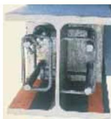
Abbildung 5: I-Profil mit Kammerbeton, links mit Kopfbolzendübel, rechts mit angeschweißter Bewehrung [207]
