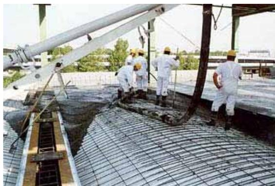
Abbildung 17: Arch Deck® und Anwendung - Einbringen des Deckenbetons [237]
