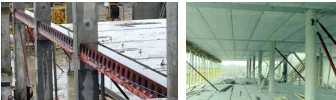
Abbildung 12: Hohldielen verlegt auf einem Delta<sup>®</sup>-Träger, Ansicht, Untersicht [224]
