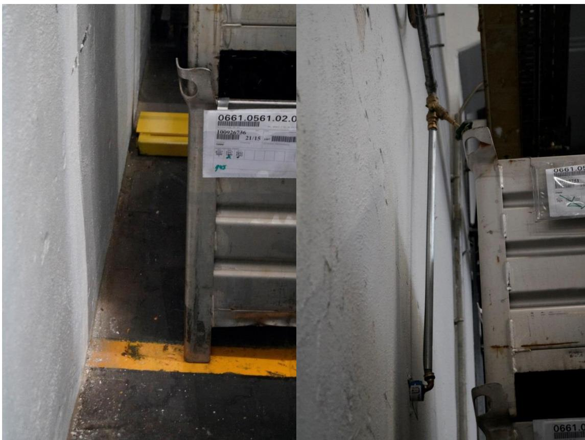
**Abbildung 36: Rohrleitungen und fehlende Bodenbegrenzungen im Bahnhof**
