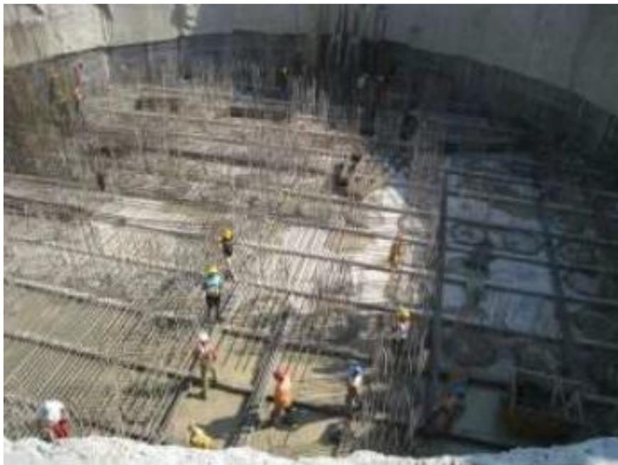
Abbildung 1.12: Herstellung der Pylonfundierung [19].
