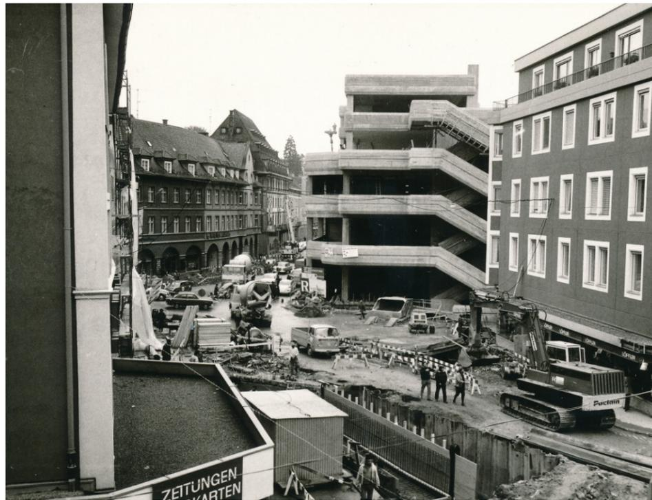
Abb.8. Vordergrund: Bauarbeiten an der Kanalisationsführung - Thalbach, Hintergrund: Rohbau GWL mit Blick in die Römerstraße, 1973
