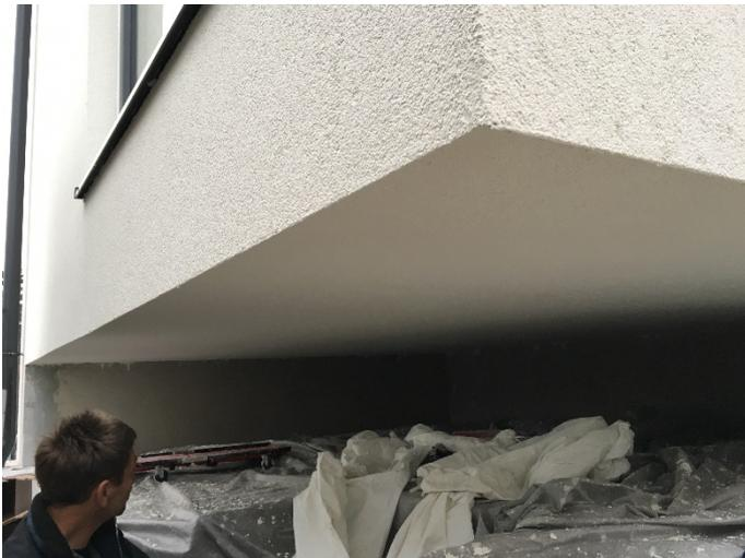
Abbildung 9-24: VWS Auskrragung fertig
