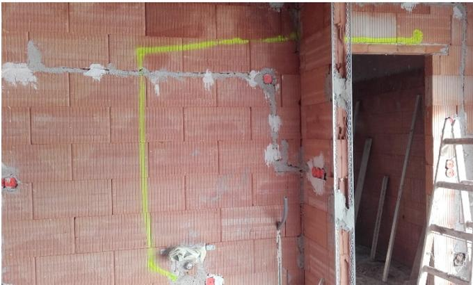
Abbildung 9-11: Fehlende Elektroerverrohrung
