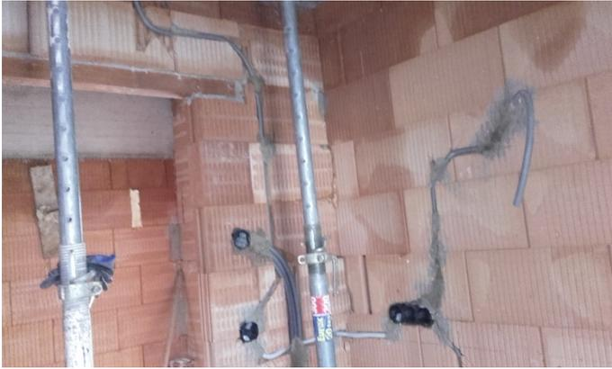
Abbildung 9-10: Falsch verlegte Elektroerverrohrungen
