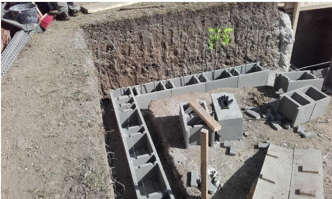
Abbildung 9-6: Schalsteine bewehrt Fundament
