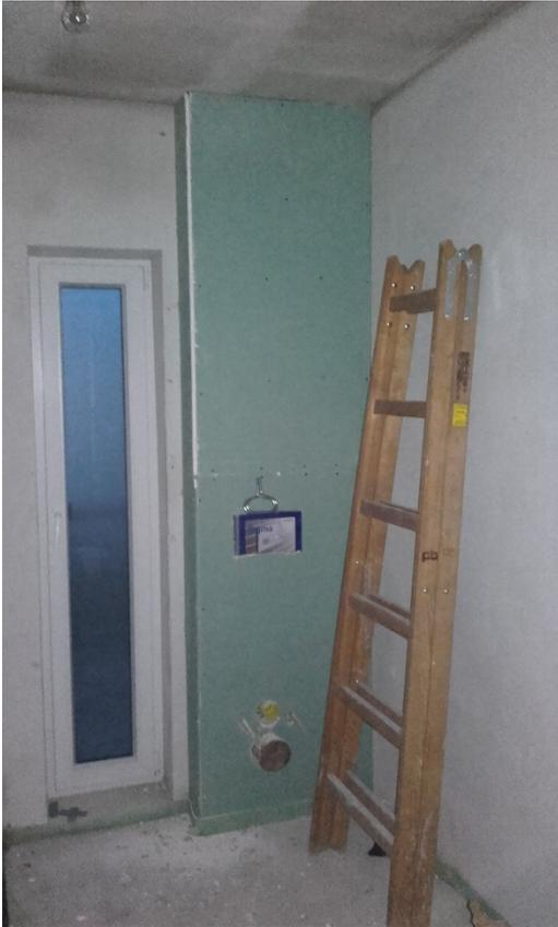
**Abbildung 9-16: Vorsatzschale Trockenbau**
