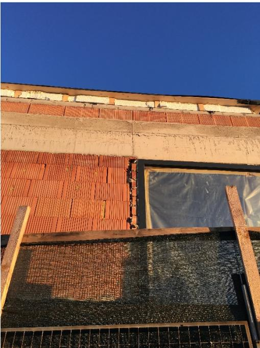
Abbildung 9-22: Falsche Ausmauerung
