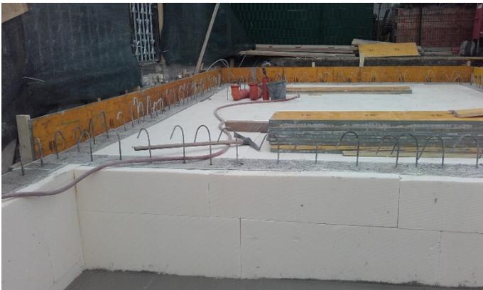
Abbildung 9-9: Bodenplatte fertig gedämmt
