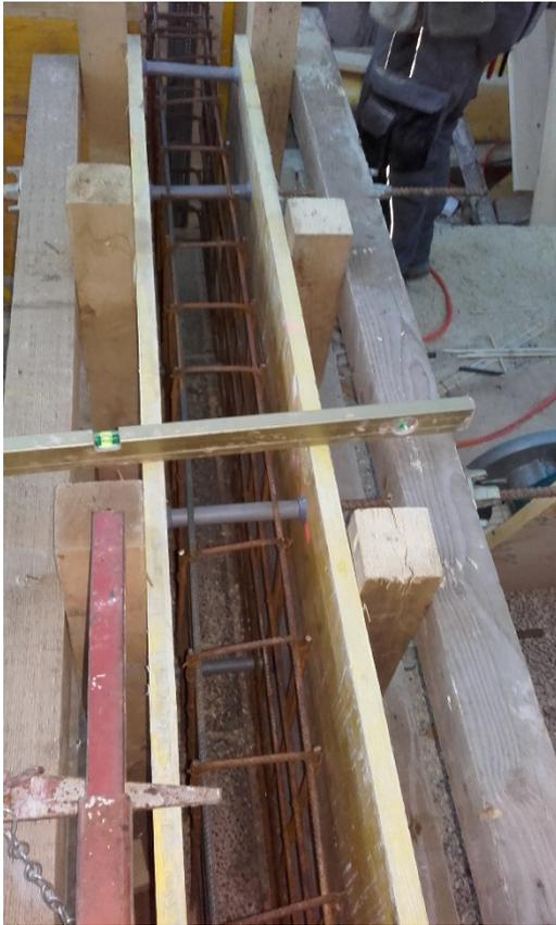
Abbildung 9-30: Schalung Sichtbeton
