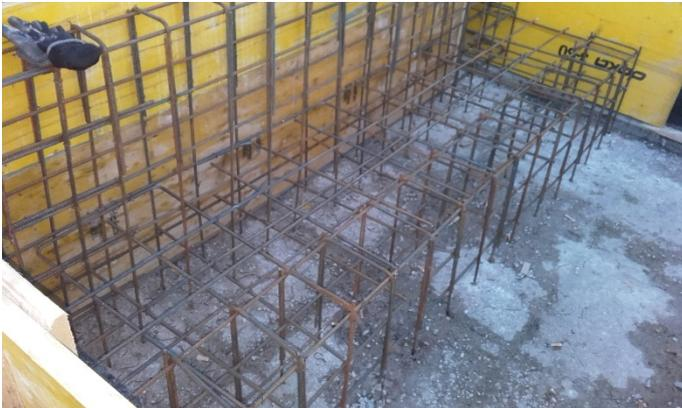
Abbildung 9-29: Bewehrungskorb Sitzstufen Außenraum
