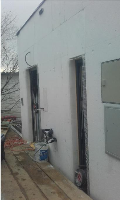
Abbildung 9-32: VWS - Dämmplatten inkl. Kantenschutz
