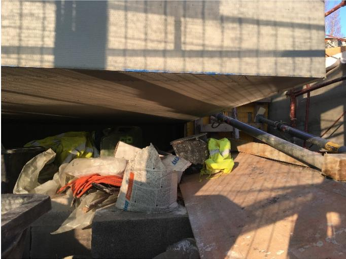
Abbildung 9-23: Kantenschutz VWS Auskrragung
