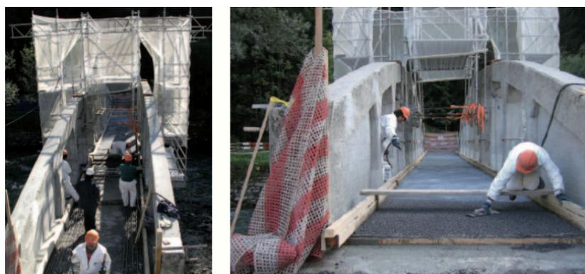
(a) Einbau der multifunktionalen UHPC-Schicht ( Verstärkung, Abdichtung und Fahrbahnbelag) [54]
