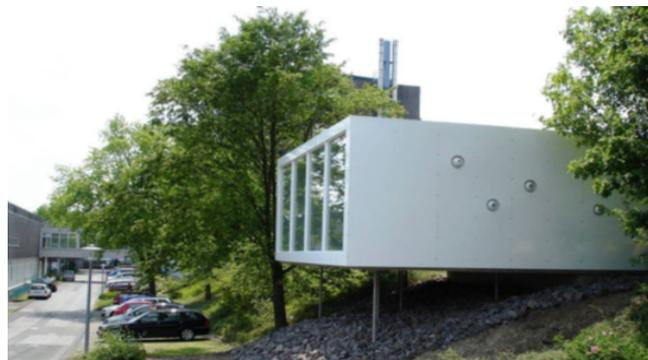
(c) UHPC-Stützen für Experimentalbau – Dröbler, Siegen [55]
