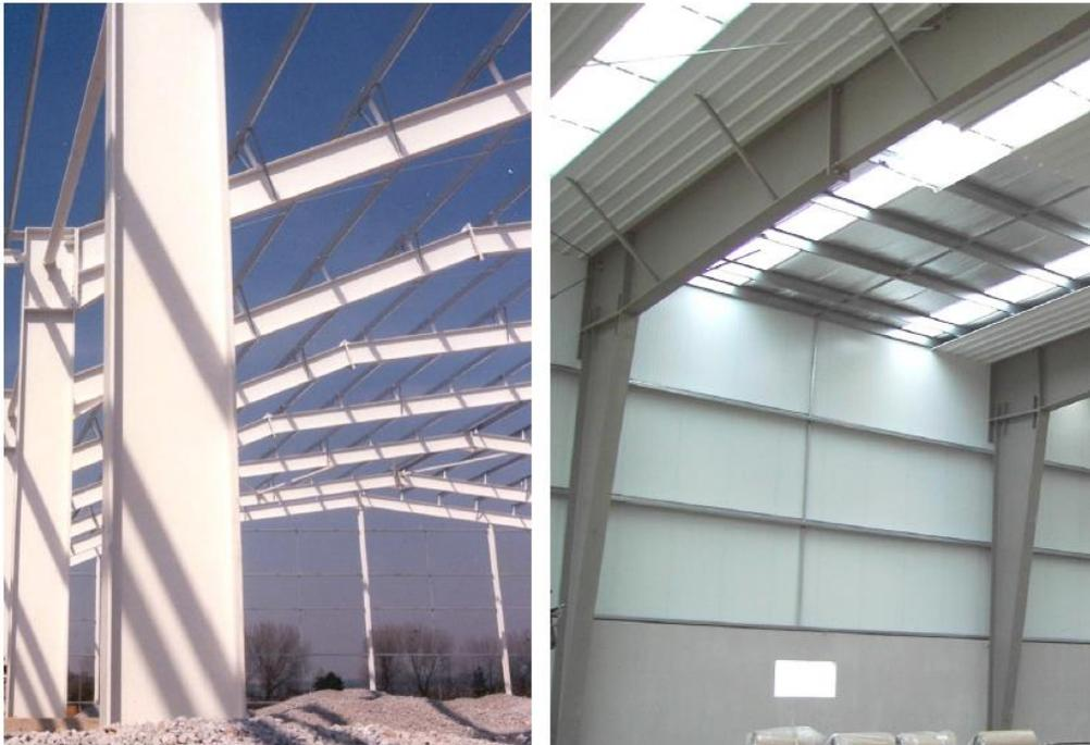
*Abb. 1-5 Beispiele für Rahmenriegel, die durch Flanschstreben ausgesteift werden*
