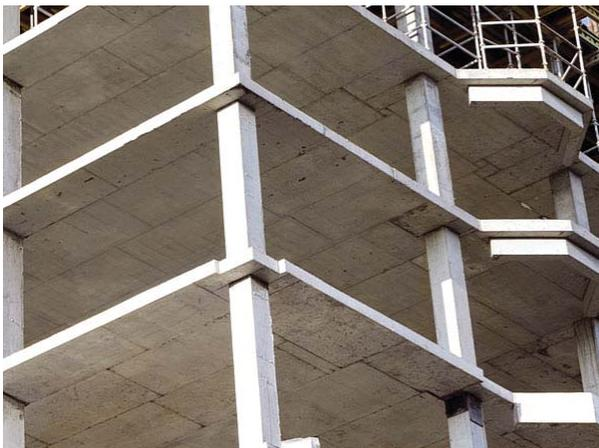
Abb.90: **Skelettkonstruktion aus Stahlbeton**
