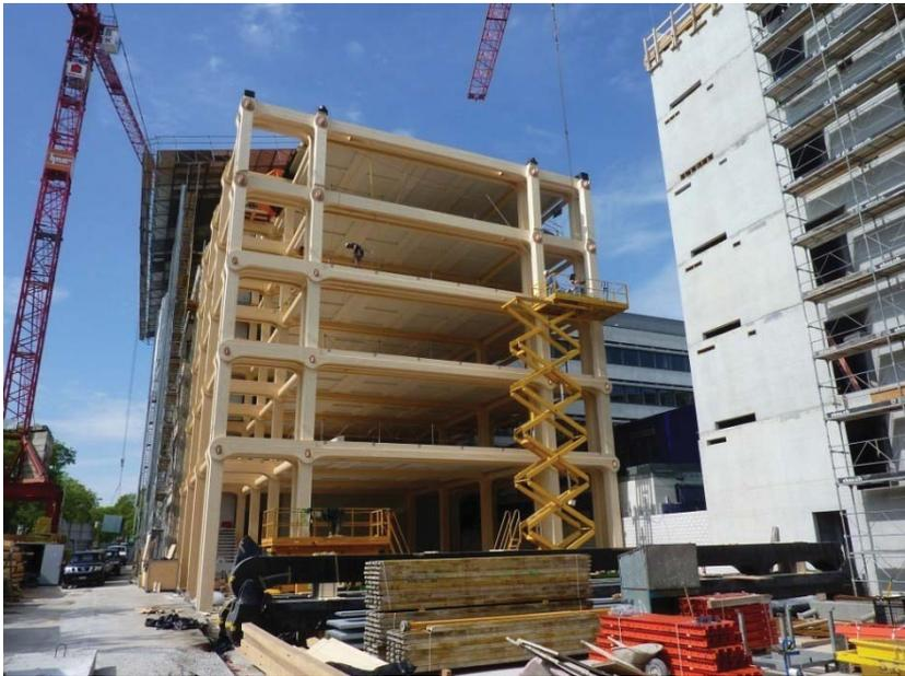
Abb. 88: Holzständer und Holzbalken als Tragkonstruktion
