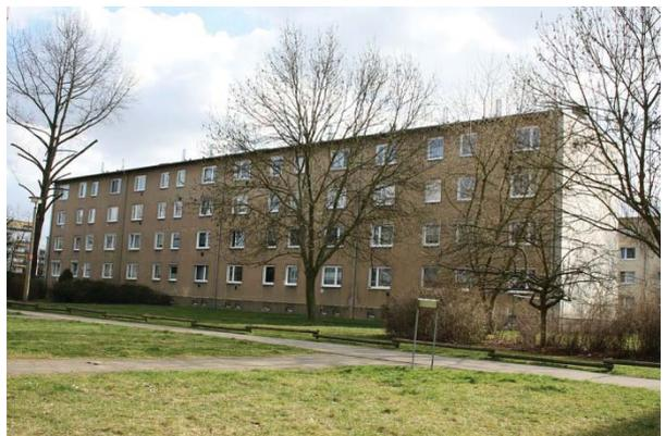
Abb.32:Ausbauphase-Typenbauweise Q3A; Deutschland
