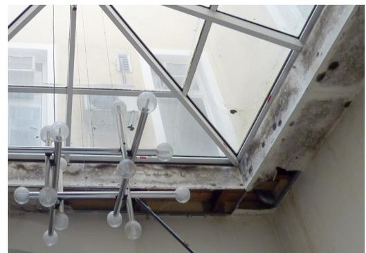
Abb. 42 Wasserschaden an der hölzernen
