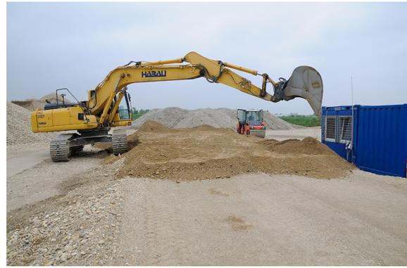
(b) Verteilung und Begradigung des Schüttmaterials der zweiten Lage des Testfeldes mittels Raupenbagger.
