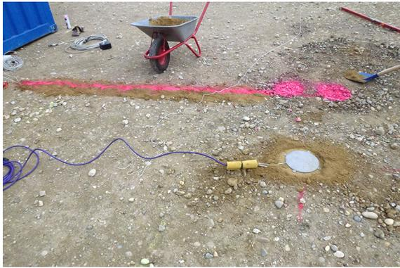
(a) Einbau der dynamischen Erddruckmessdose unter der Spur 2 des Testfeldes.
