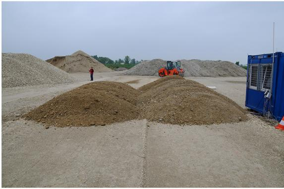
(a) Loses Schütten des sandigen Kieses für die zweite Lage des Testfeldes durch einen Muldenkipper.
