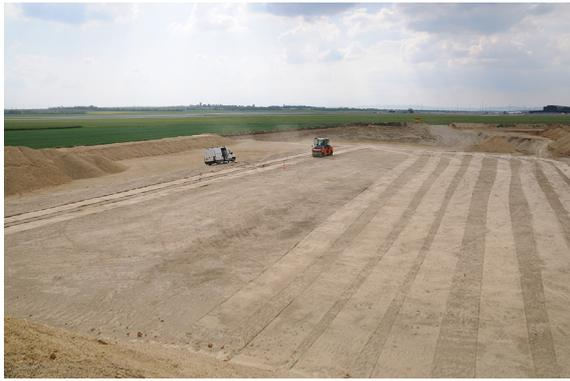
(a) Spuren 6 und 7 (im Hintergrund) und zusätzliche Messspuren auf dem bindigen Untergrund.
