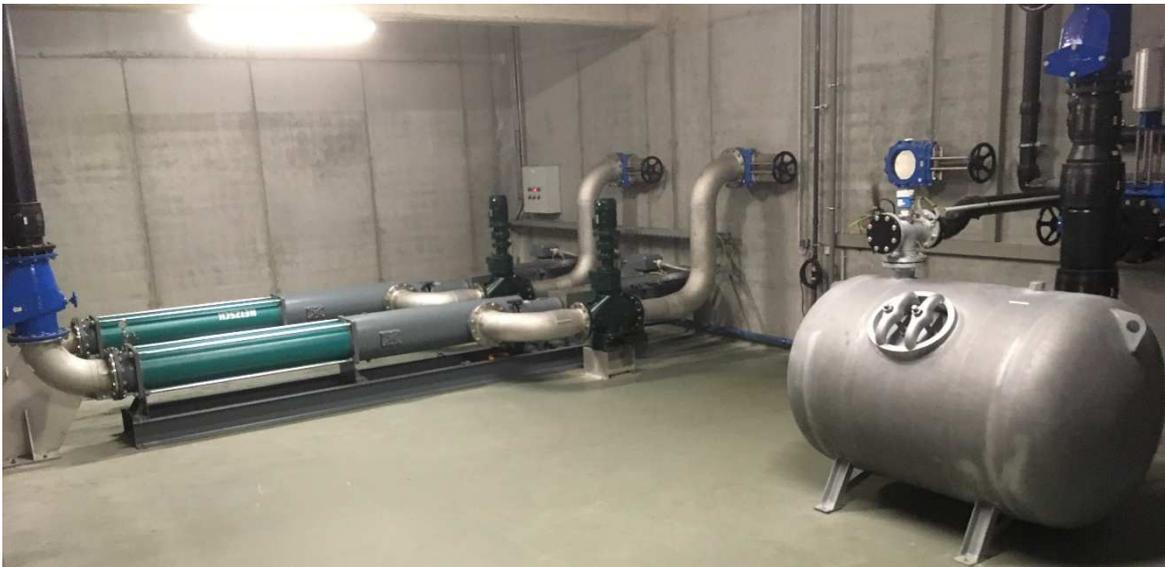
Abbildung 4.7: 2. Untergeschoß des HPW Dürnrrohr (G01) mit zwei Exzentrerschneckenpumpen und einem von zwei Arbeitskesseln der pneumatischen Anlage
