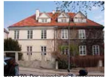
FIG.170. Dos viviendas en *Suttingergasse* 12 y 14, en Viena, de Josef Hoffmann. La aparente perfecta simetría, en cuyo eje se sitúan las dos bajantes de pluviales, se rompe eliminando una ventana en el piso superior de la vivienda de la derecha. Asimismo la cubierta, con la disposición de las chimeneas y las ventanas de los desvanes (dos en una casa y una en la otra) también resalta este juego entre asimetrías.
