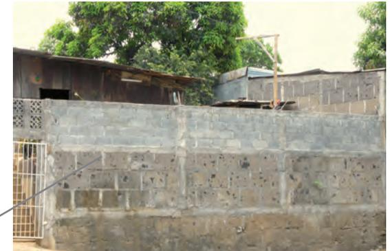
Systematik des eingefassten Mauerwerks mit Stahlbetonrahmen bei Confined Masonry
