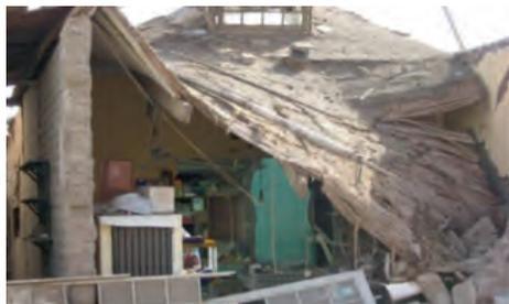
5 - Eingestürztes, auf der Fassade gelagertes Dach
