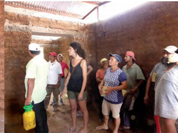
29 - Ein Bauarbeiter (links) wässert die Wand mit einer Sprühpumpe. Die Gruppe wartet aufs Verputzen, wofür alle die Schaumstoffe in den Händen halten.
