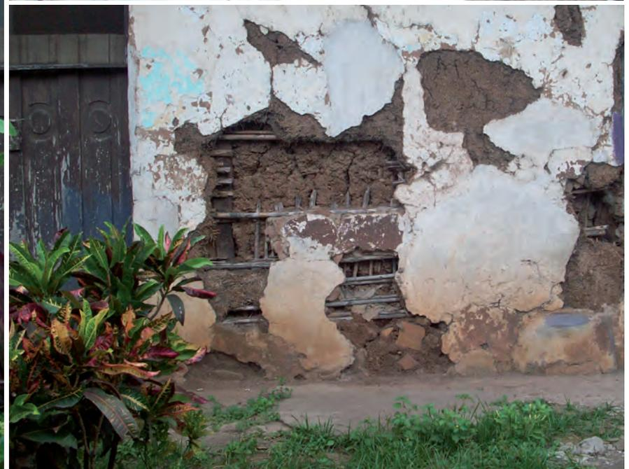
24 - 26 - Der schichtartige Aufbau der Wand mit den horizontalen und vertikalen Stäben aus Zuckerrohr *caña*.
