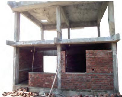
Beispiel eines Stahlbetonrahmenbaus mit nicht bewehrtem Mauerwerk
