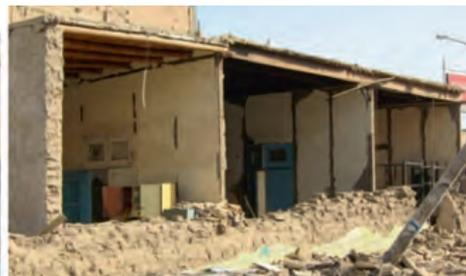
6 - Das auf Querwänden gelagerte Dach bleibt bestehen
