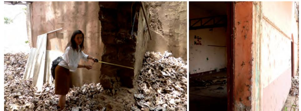
18, 19 - A2. Trennwände: Vergleich 60 cm dicke Adobe-Wände (links), Taquezal-Wand mit ca. 25 cm (rechts)
