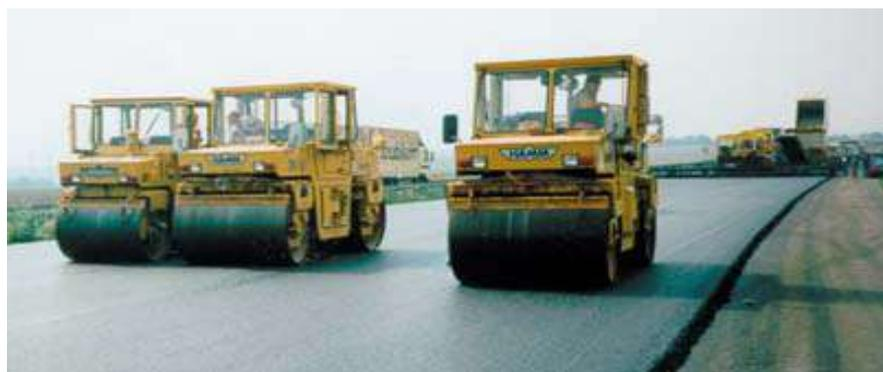
**Abb.13 Einbau von Walzasphalt**
