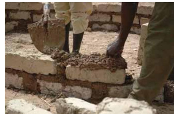
Abb. 37: Bau einer Ziegelwand
