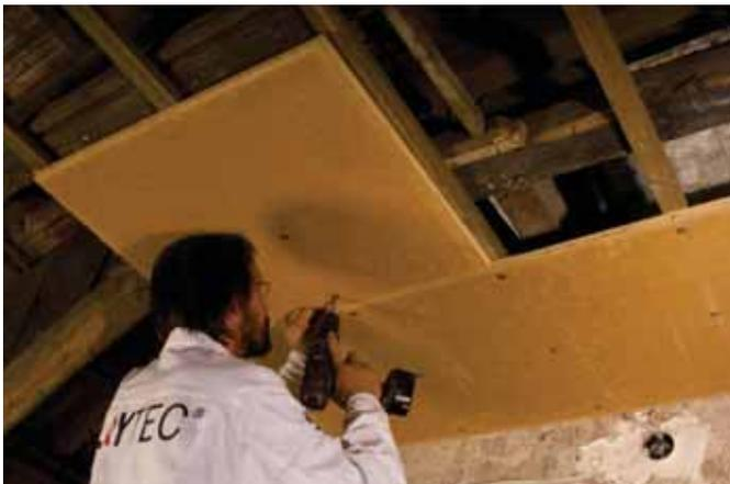
Abb. 64: Montage von Lehmbauplatten
