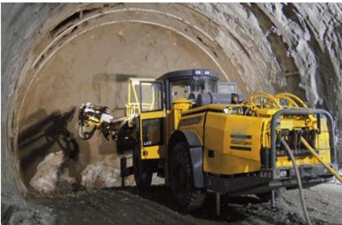
Abb. 3.14: Bohrwagen beim Einbringen von Ortsbrustankern<sup>54</sup>
