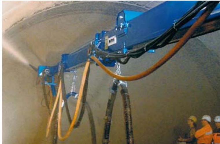
Abb. 3.16: Spritzmobil beim Aufbringen des Spritzbetons in der Kalottenlaibung<sup>59</sup>
