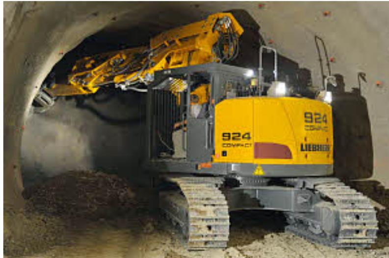
Abb. 3.10: Hydraulikbagger beim Öffnen der Ortsbrust<sup>47</sup>
