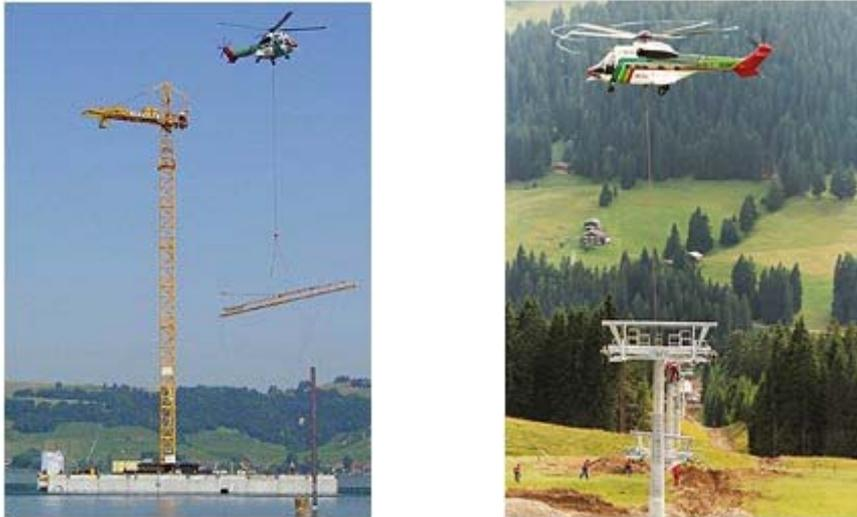
Abb.67: Hubschrauber bei Kranmontage bzw. bei Seilbahnbau<sup>122</sup>
