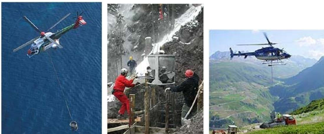
Abb.66: Hubschrauber beim Betontransport<sup>121</sup>
