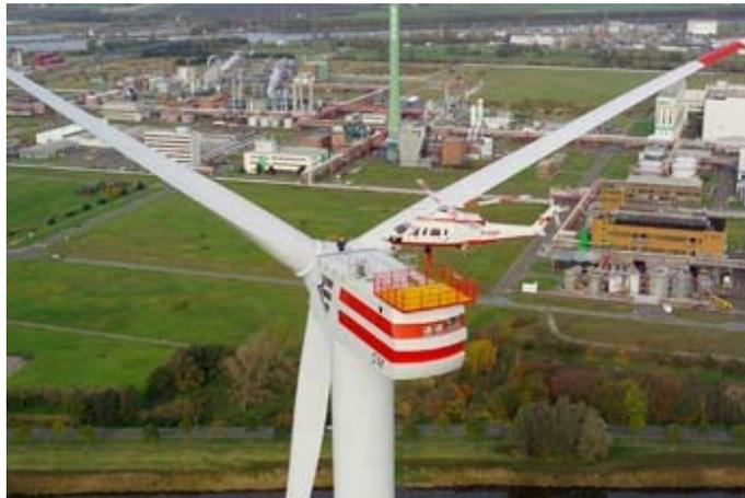
Abb.68: Hubschraubereinsatz beim Bau von Windkraftanlagen<sup>123</sup>
