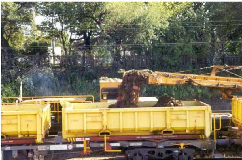
Abb.57: Förderband bei Bahnverladung <sup>110</sup>
