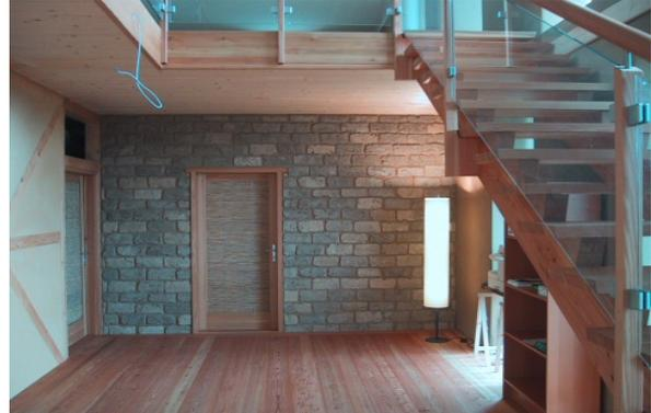
Abbildung 2.1 Links: Beispiele für industriell gefertigte Lehmsteine (Minke, S.119 /1/); Rechts: Beispiel für ein Sichtmauerwerk aus Lehmziegeln (/49/)
