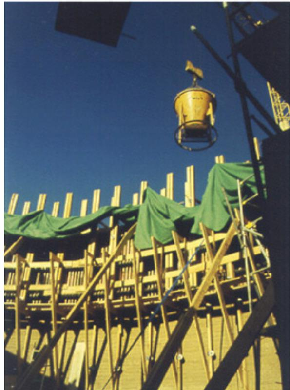
Abbildung 2.2 Stampflehm (Links: Pollak/Richter, S.82 /9/; Rechts: Einbringen des Lehms mittels Krankübel bei einer Stampflehmwand, Kapelle der Versöhnung, Berlin /50/)
