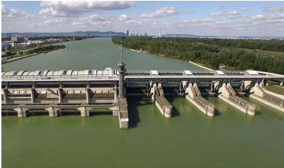
Abb. 2.32 Würde man auf eine „Störung“ des Gewässersystems wie das Kraftwerk Freudenuau nicht durch eine kompensatorische Maßnahme in Form des künstlichen Einbringens großer Geschiebemengen im Unterwasser reagieren, dann...
