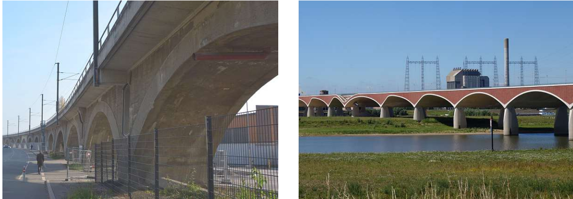
Abb. 2.14: Ansicht eines Ausschnitts der Floridsdorfer Hochbahn (Italienschleife) (links); Ansicht eines Ausschnitts der nördlichen Vorlandbrücke von De Oversteek in Nijmegen (Niederlande) (rechts)
