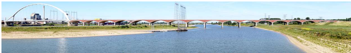
Abb. 6.1: Ansicht der nördlichen Vorlandbrücke von der Stadsbrug Nijmegen (Niederlande)
