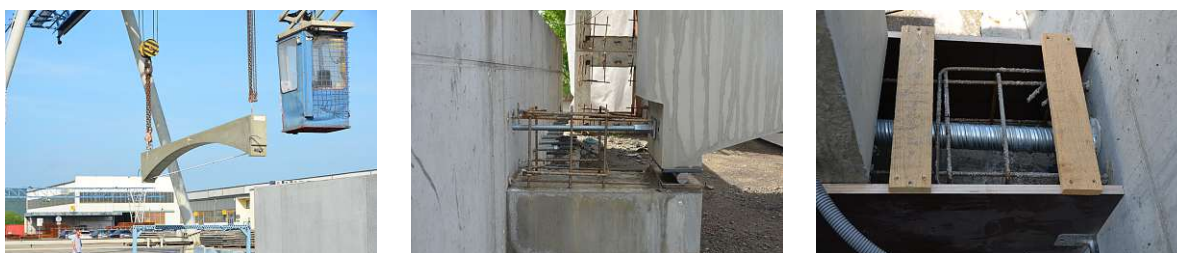
Abb. A.3: Versetzen Bogenträger mittels Portalkran (links); Detail Kopplung Zugband bei Verbindungsstück 1 (mittig); Detail Verbindungsstück 1 vor der Betonage (rechts)
