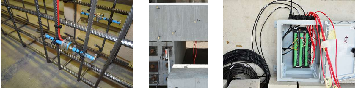
Abb. A.7: Messtechnik: Schwingsaitensensoren im Scheitelbereich vor der Betonage (links); Wegaufnehmer im Scheitelbereich (mittig); Messstation für kontinuierliche Messungen und Aufzeichnungen (rechts)
