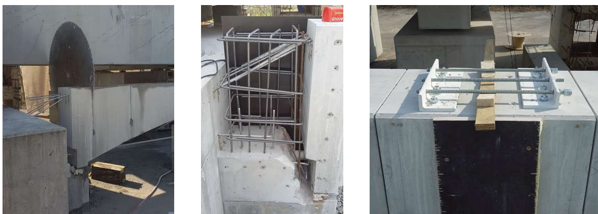
Abb. 4.12: Umbauarbeiten von Variante I zu Variante II: Schneiden der Schlitzte mit einer Betonkreissäge (links); Bewehrung für die Ergänzung Anschluss Widerlager 1 (mittig); Kraftschlüssige Verbindung der Schlitzte aus Variante I über dem Fundament 2 beziehungsweise 3 (rechts)
