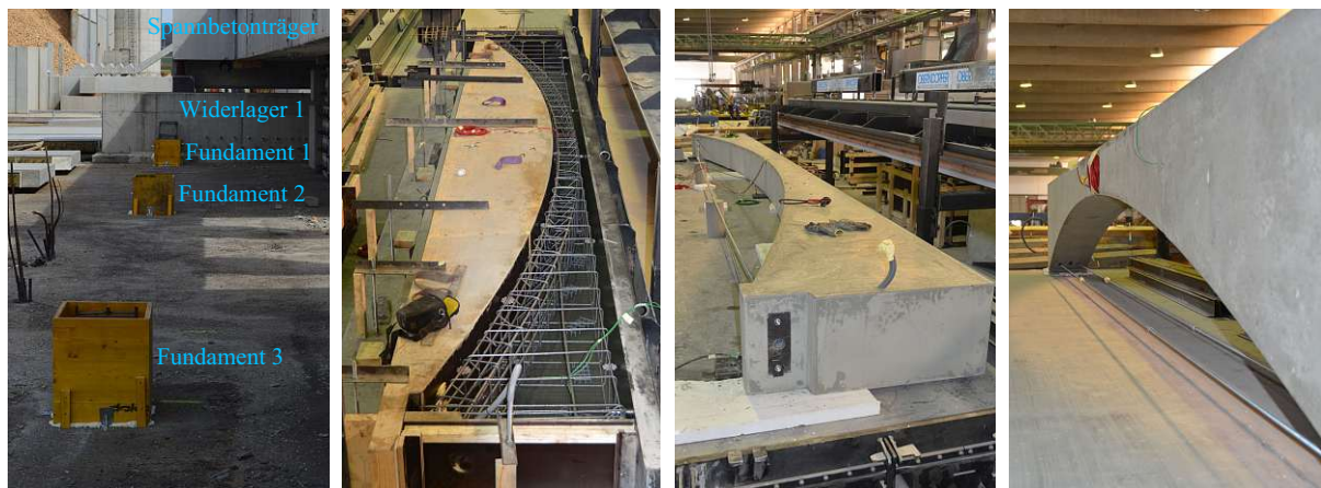
Abb. 4.7: Vorarbeiten: Schalungen Fundamente (links); Bewehrungskorb Bogenträger (3.v.re.); Einbau temporäres Zugband (2.v.re.); Aufgerichteter Bogenträger (rechts)
