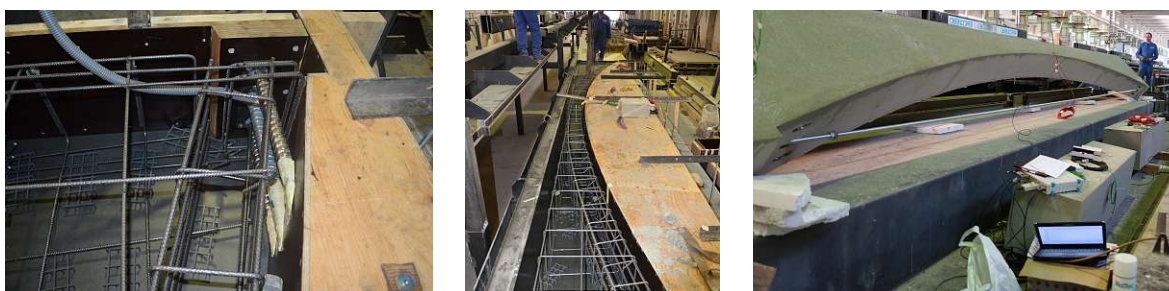
Abb. A.2: Herstellung Bogenträger: Detail Bogenfußpunkt - Hüllrohre für Durchführung Zugbänder (links); Betonage (mittig); Aufdrehen aus der liegenden Position (rechts)
