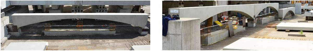
Abb. 4.9: Bogenträger 1 versetzt (links); Bogenträger 1 und 2 versetzt (rechts)
