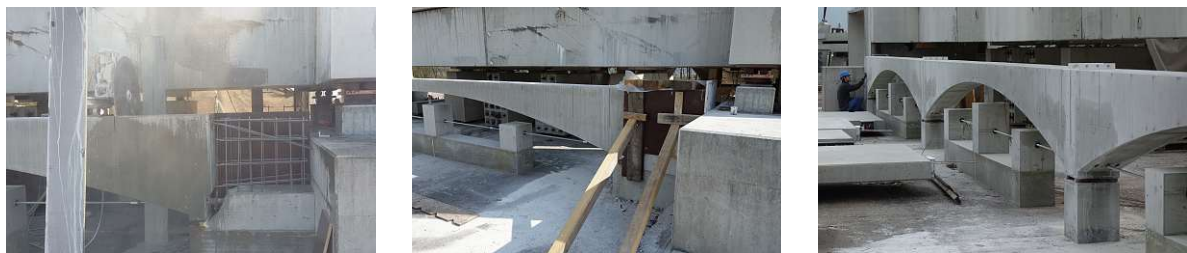
Abb. A.6: Umbau des Prototyps auf Variante II: Schneiden eines Schlitzes (links); Herstellung Ergänzung Anschluss Widerlager 2 (mittig); Fertiggestellter Prototyp Variante II (rechts)
