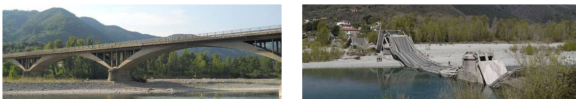
Abb. 2.11: Ansicht der Albiano Magra Brücke: Intakte Konstruktion (links) 1 ; Nach dem Einsturz im April 2020 (rechts) 2
