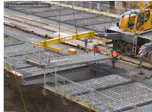
(b) A3 Würzburg Talbrücke Heidingsfeld: Versetzen eines Halbfertigteilelements (Copyright: Autobahndirektion Nordbayern)
