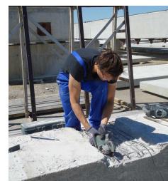
(c) Freischneiden der freigelegten Bewehrung
