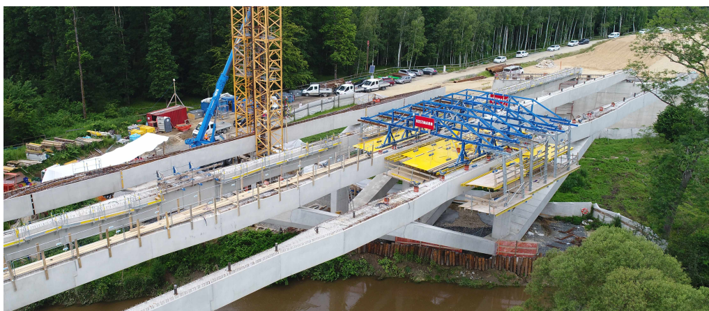
Abb. 2.1: Schalwagen auf der Brücke über die Lafnitz (Copyright: TU Wien, Kollegger)
