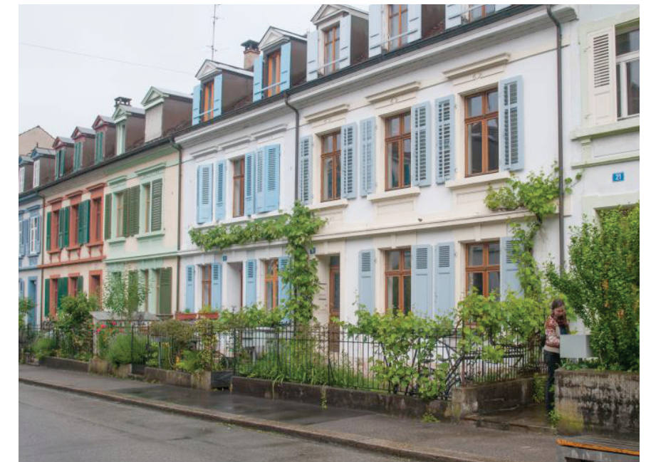
Abb. 20: Schweizerstrasse, Häuser für Arbeiter*innen der Seidenfabrikation. Zweigeschoßige Reihenhäuser, „erster Bautyp“ der Stadterweiterung.
