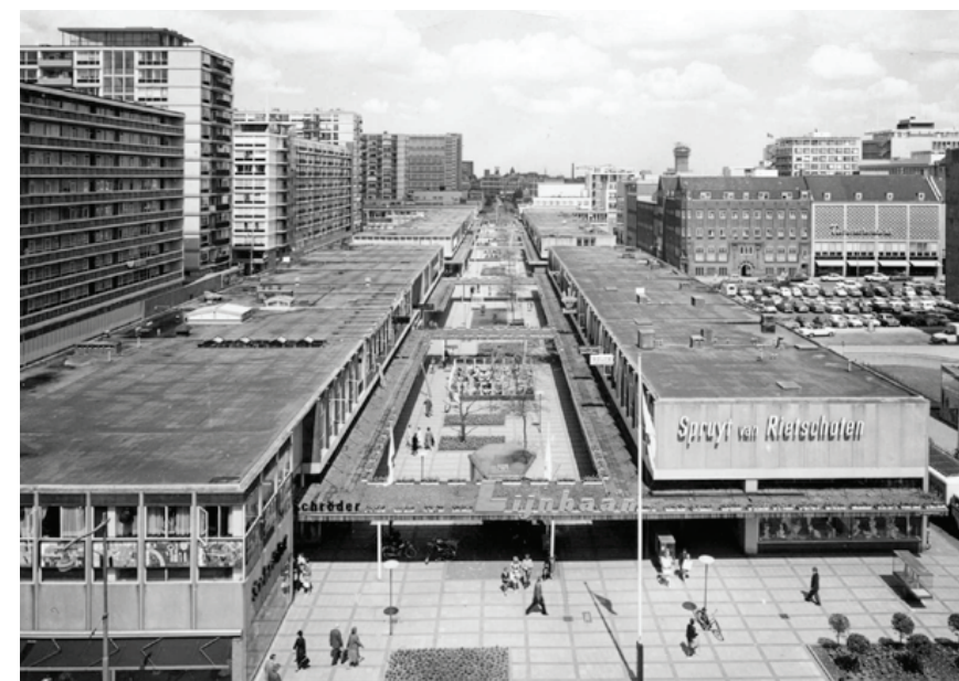
Abb. 39: Rotterdam, Lijnbaan: Die erste reine Fußgänger*innenzone Europas. Die Wirkung ist eher die einer Mall als eines städtischen Raums.
