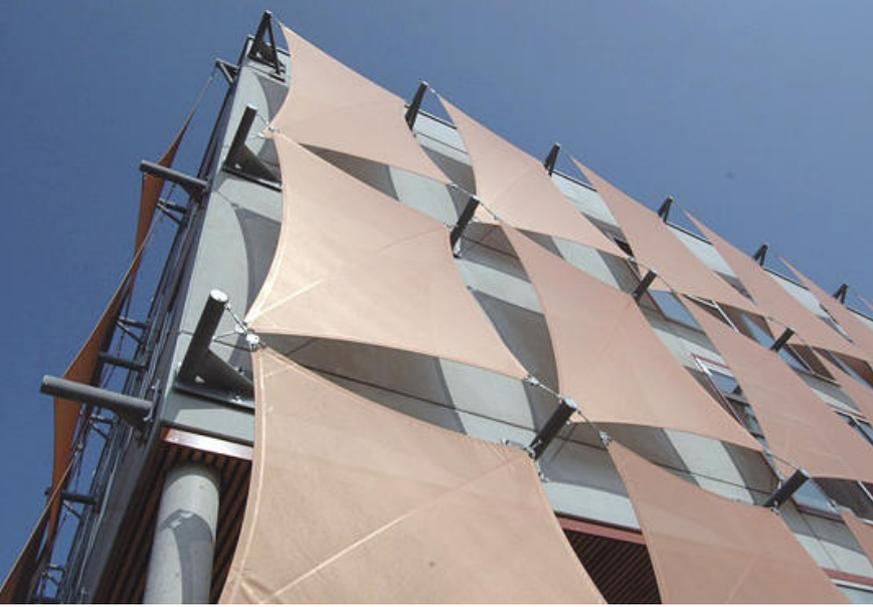
Abb. 21: Sonnenschutzfassade
