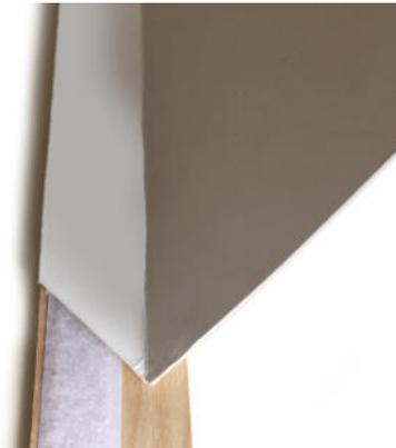
Abb. 68: Verbindung mit Klettbändern
