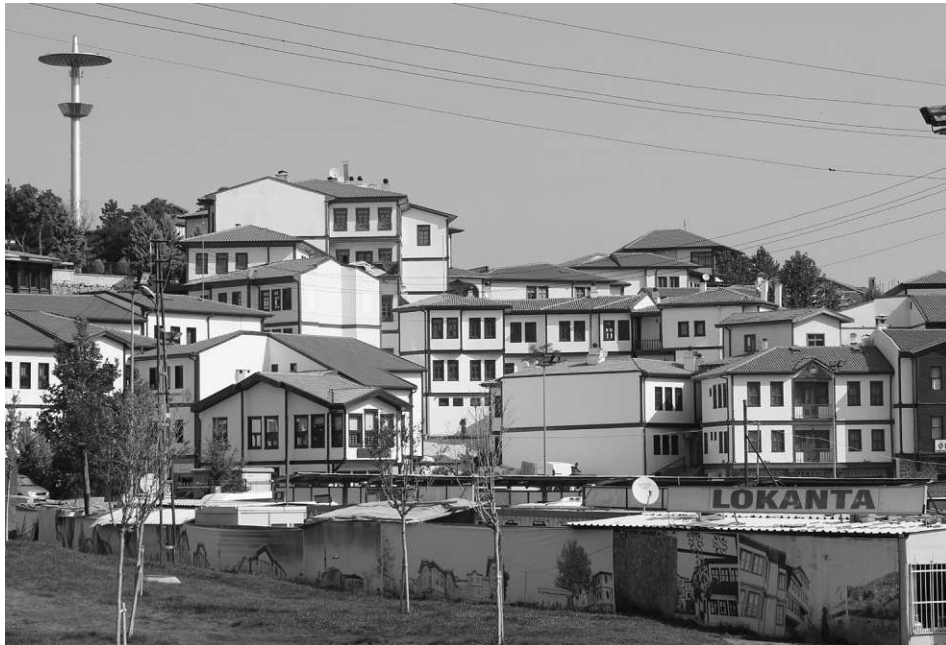
Abb. 9: Sanierte Konakbauten in Ankara, Türkei
