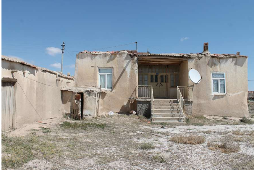
Abb. 73: Lehmhaus mit Sanitäreanlage und Vorratsraum in Gemecik
