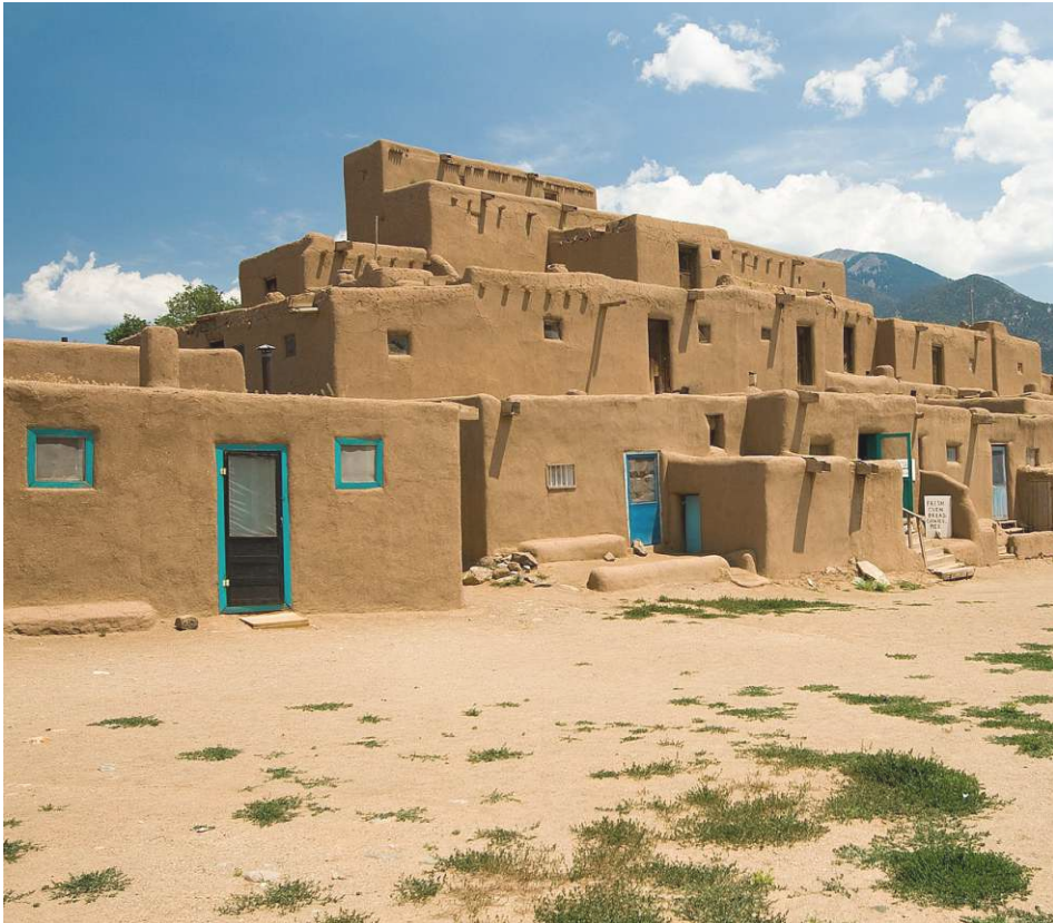
Abb. 23: Lehmhäuser in Taos Pueblo
