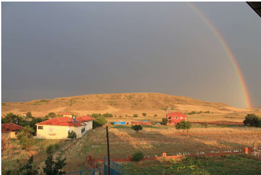
Abb. 67: Stahlbetonhäuser in Meşeyayla
