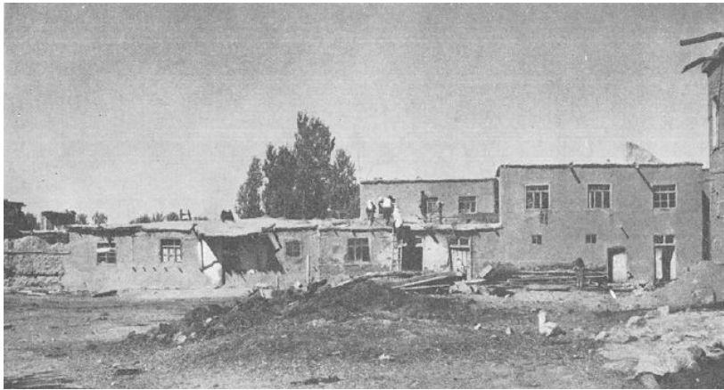
Abb. 51: Lehmhäuser in Aşağı Ağınsı
