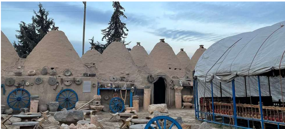
Abb. 76: Lehmkuppelbauten in Harran
